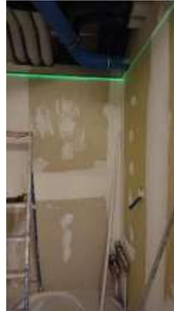
Les alimentations électriques sont sorties au niveau des urinoirs alors que le modèle mis en place est sur batterie.
