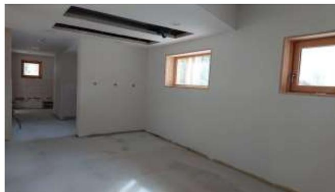
Les peintures du rez-de-chaussée sont terminées en dehors des portes et la finition de la cloison séparative depuis fin février . Faux plafond en cours de pose au sous-sol :
