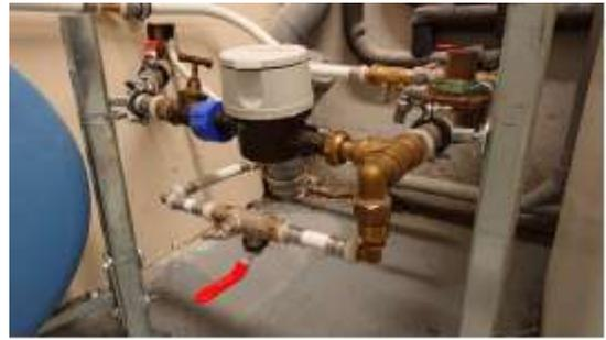
L'ensemble de la pose de l'appareillage est en cours. Le service des eaux doit effectuer le plombage.
