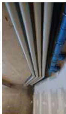
Les passages des gaines seront bouchés pour permettre la finition du placoplâtre côté local de rangement du sous-sol.
