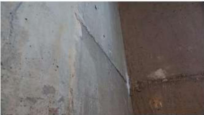
Il reste à voir pour la préparation du mur en béton du sous-sol en cours, avec le dé-bullage, le rebouchage et le ponçage des grosses aspérités pour la mise en peinture.
