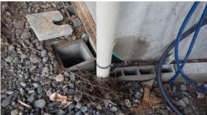
La descente des eaux pluviales côté sud sera raccordée de façon provisoire dans le regard souple pour éviter l'humidité sur le mur.
