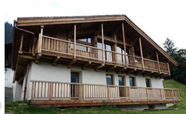
Les balcons généralisés, sur toute la largeur de la façade
