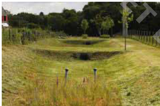
Exemple d'une noue de grande capacité
