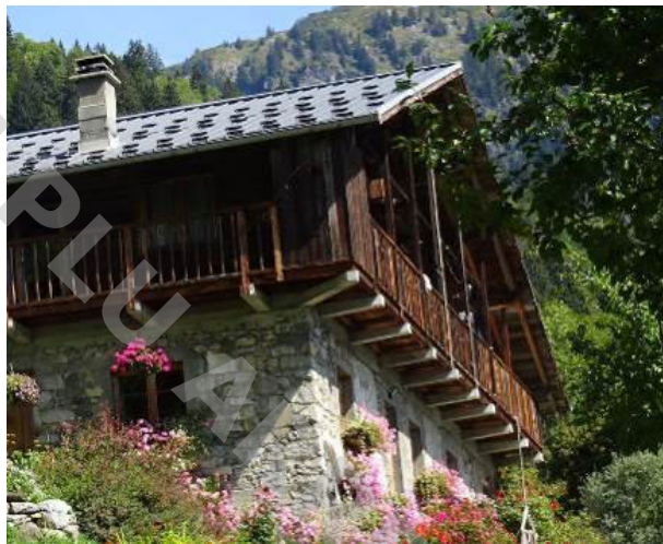
Les supports de balcons en béton
