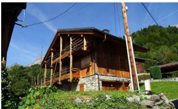
Les galeries transformées en grands balcons
