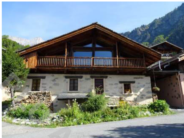
Les traitements fantaisistes de l'enduit, le faux rustique
