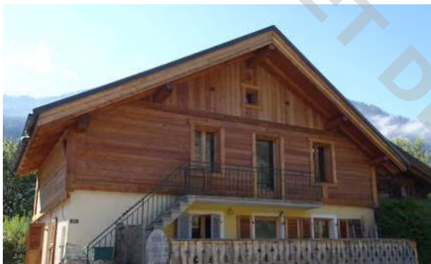
L'isolation au-dessus des chevrons se voit à l'épaississement des bandes de rives
