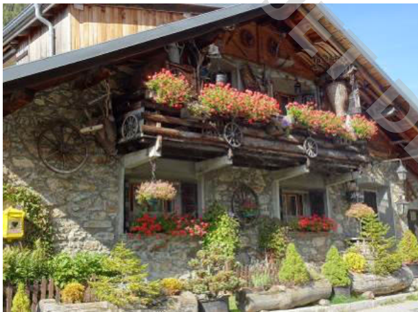
Le décaottage de l'enduit, les joints au ciment
