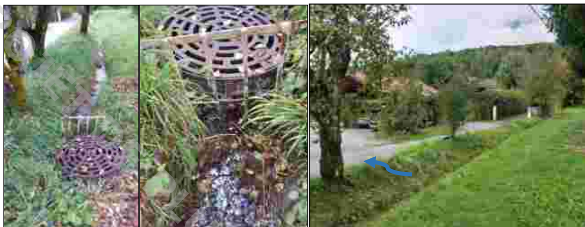
Thalweg et grille d'entonnement
