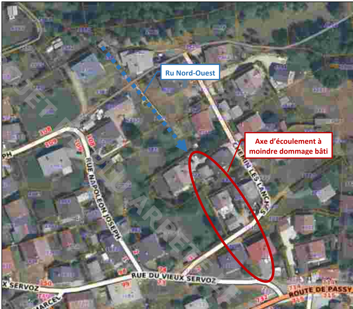
Constructions au niveau de l'axe d'écoulement à moindre dommage du ru Nord-Ouest
