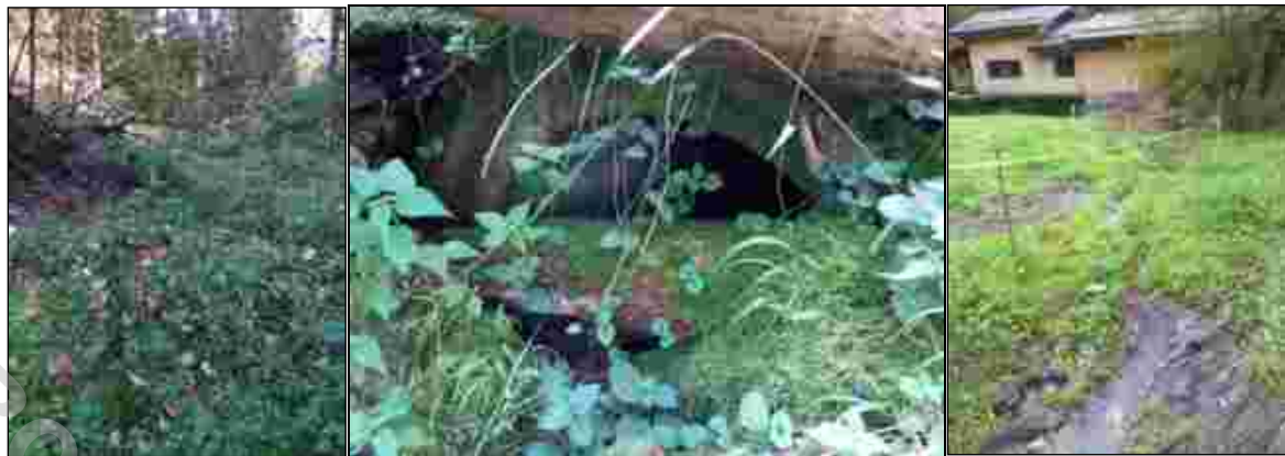
Thalweg partiellement remblayé
