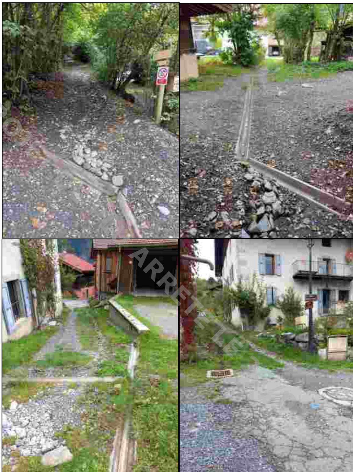
Chemin amont et cunettes
