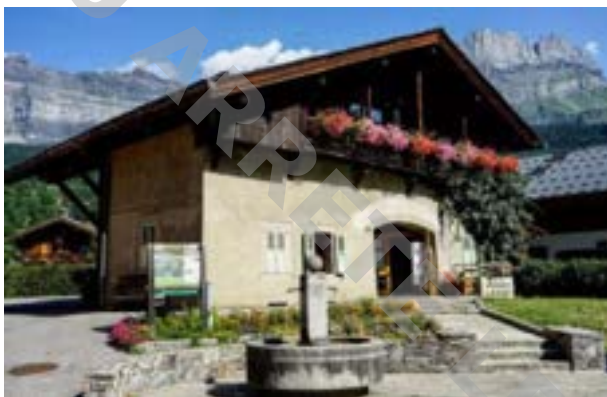
La maison de l'Alpage, Rue du Bouchet
