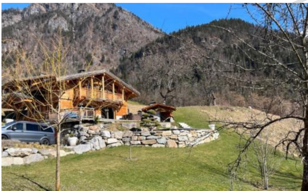
Partie haute de l'OAP des Moulins d'en Bas vue depuis le chemin de la Bosna.
