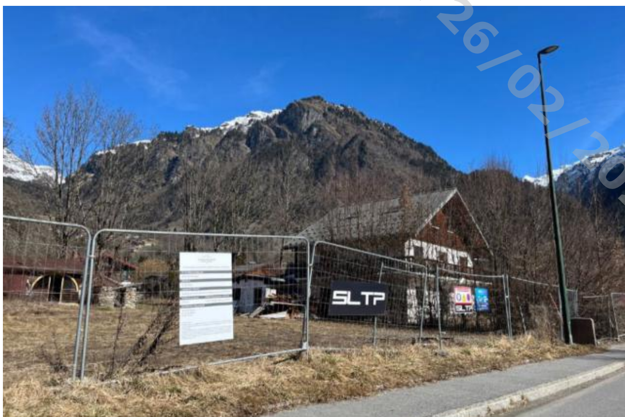
Constructions existantes dans le périmètre de l'OAP avant leur démolition courant 2025
